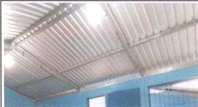
Foto 2: Sustitución de estructura de madera por metal.
