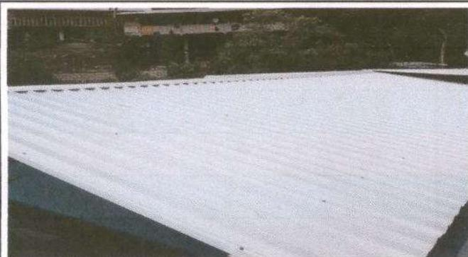
Foto 1: Sustitución de lamina por lamina troquelada Alucin.
