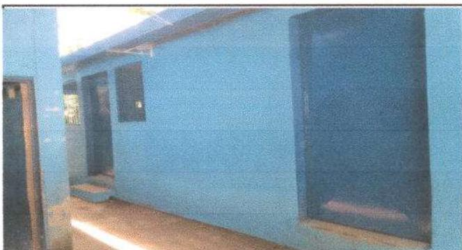
Foto 3: sustitucion de puertas de madera por metal.
